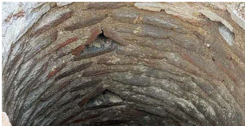
El pozo de registro hallado durante la acometida este verano.
